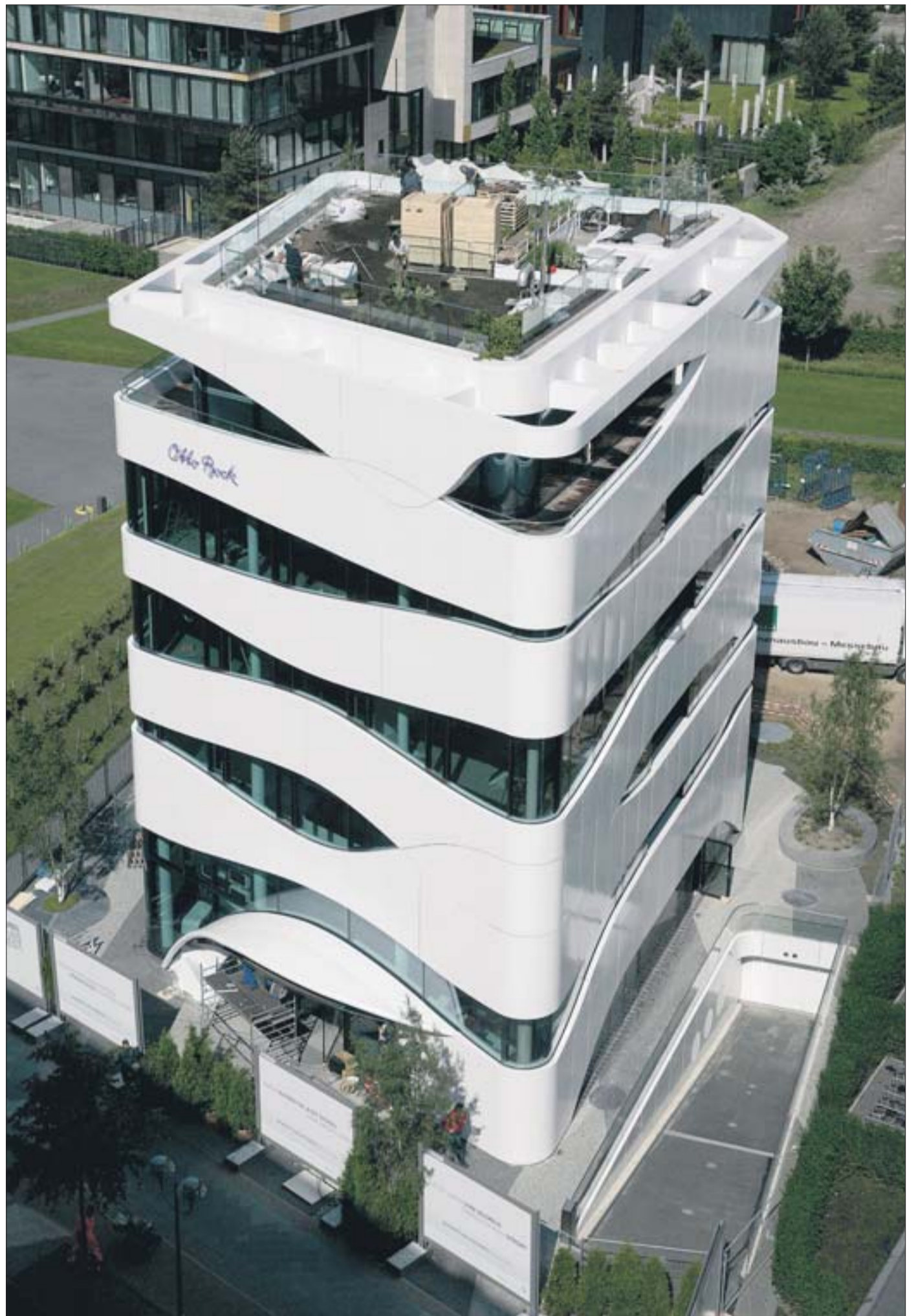
Imposante Architektur in der Ebertstraße: Die Fassade des Otto-Bock-Science-Centers ist ein echter Hingucker. EF
