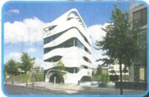
So sieht das Science Center von außen aus.
